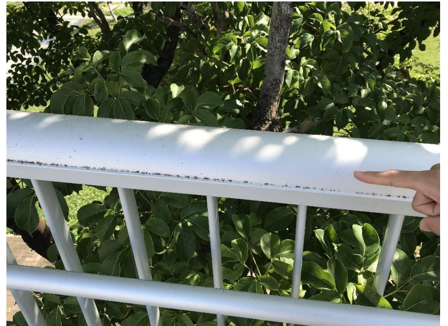
2023年1月16日 施工 場所
