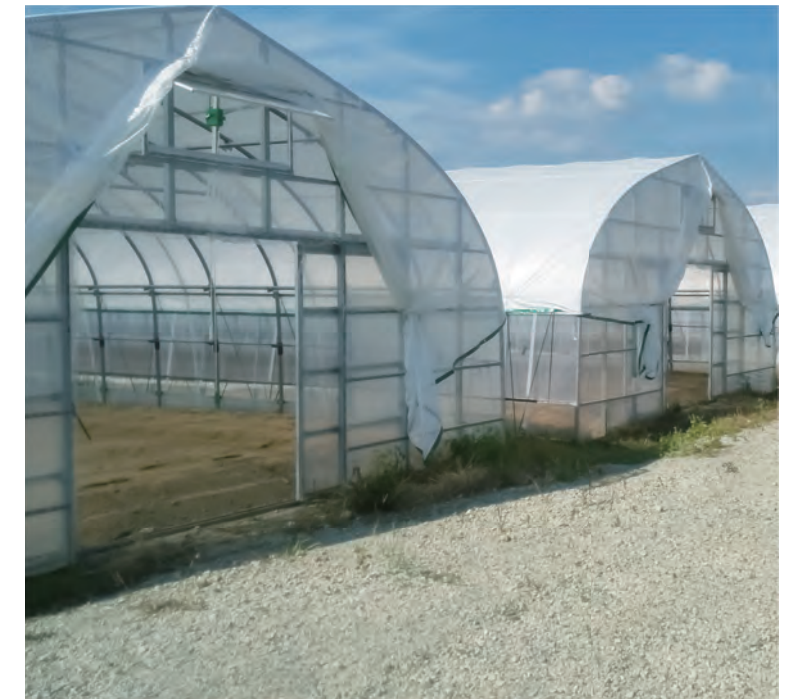
パイプハウス施工
