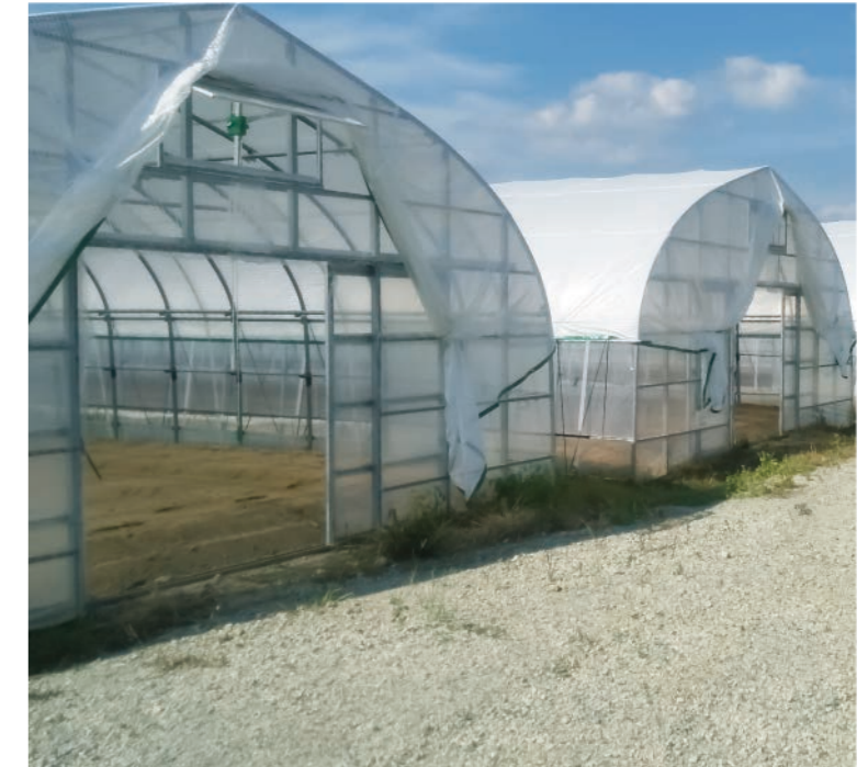
パイプハウス施工
